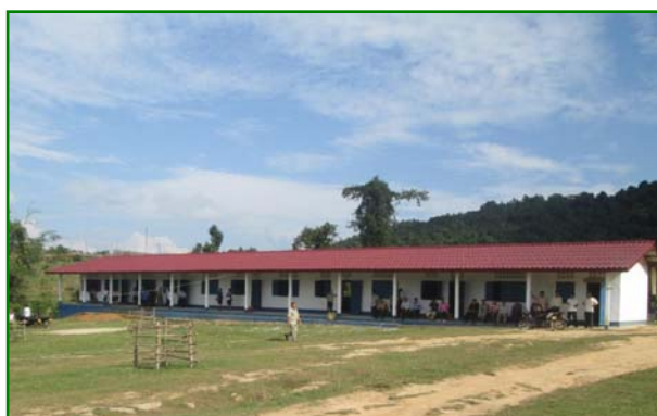
Bâtiment-1 avec salle informatique
