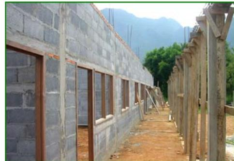
*L'École en construction. L'orientation a été modifiée en fonction des vents pour une meilleure ventilation. Les nouveaux sanitaires sont situés derrière l'ancienne école.*
