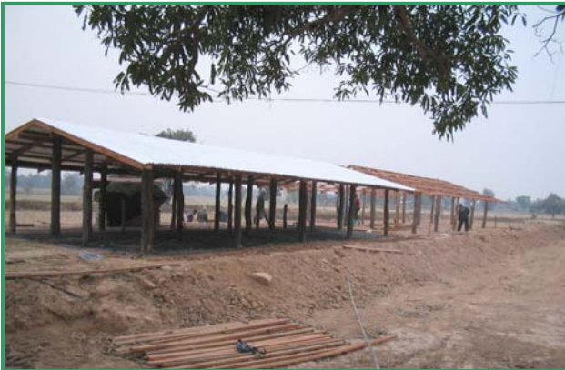
Structure Béton, Bois, Tôle de Zinc. Ligne électrique pour pompe à eau.
